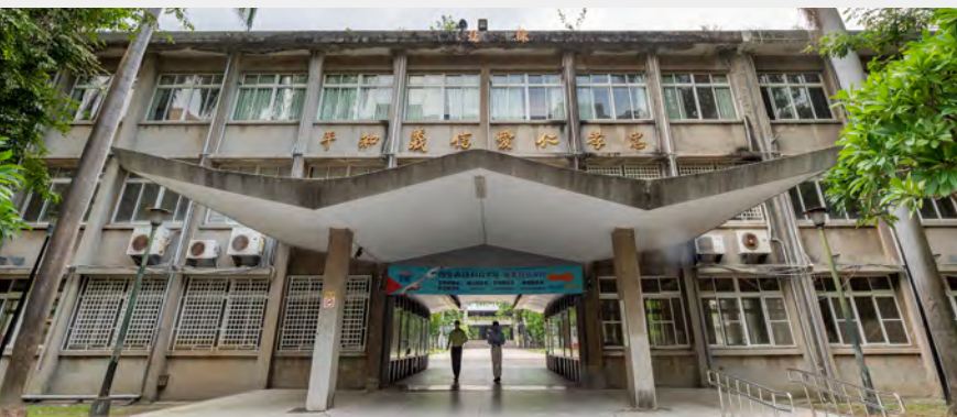
▲ 北向門廊、穿廊與 W 形折版雨庇
